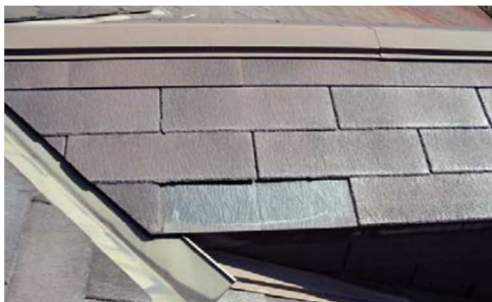
石綿含有住宅屋根用化粧スレート
