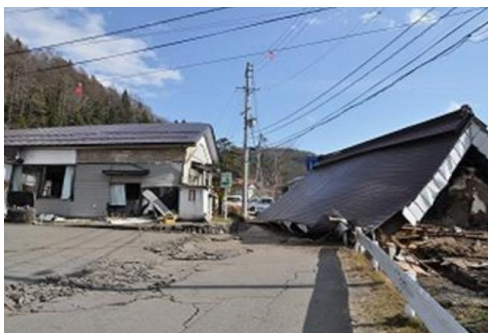
平成26年神城断層地震による民家等の倒壊 (出典：長野県耐震改修促進計画(第II期))
