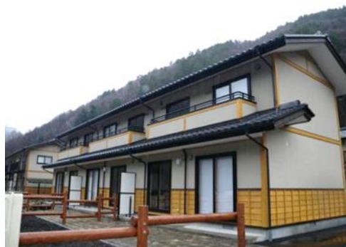
長野県産材を活用した公共施設 (木曾町営住宅)
