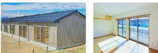
リニューアルによる長寿命化と居住環境の改善
