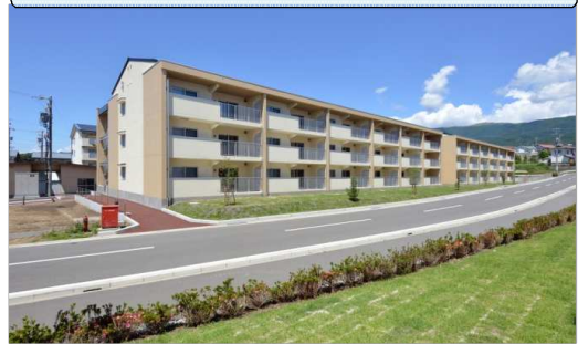
《H23～25建設 君石団地(塩尻市)》
