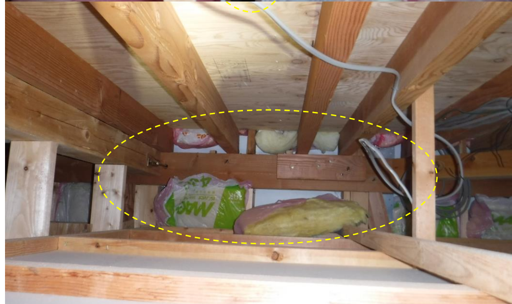
階間部分(1階の天井裏)
