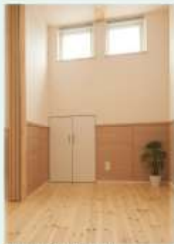
換気と威力を発揮する高窓
