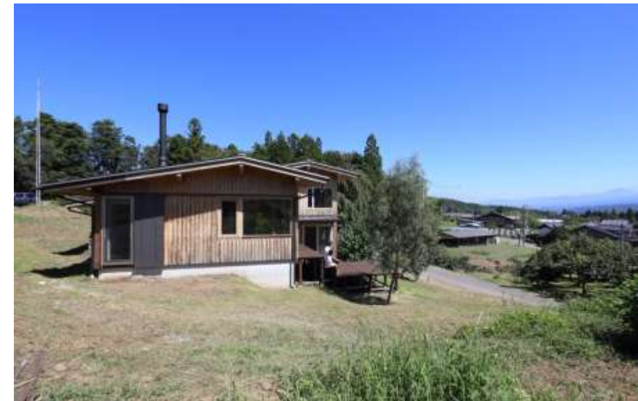
伊那谷を望む家。緩勾配の切り妻屋根の繰り返し
