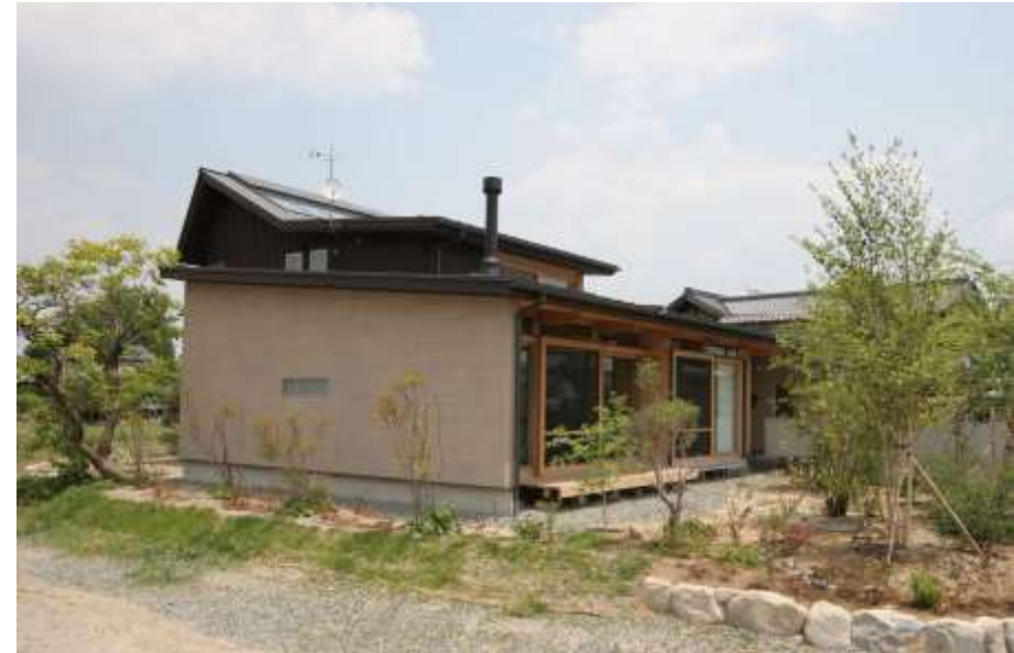
ゆったりとした勾配の平屋部分と、太陽熱集熱を考慮した2階の屋根形状
