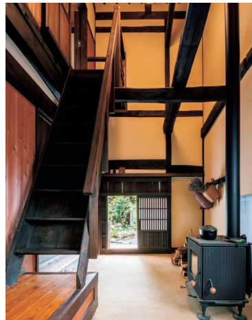
復活させた三和土による土間と吹抜け
