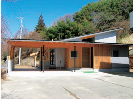
片流れ屋根によるすっきりとした水平ライン
