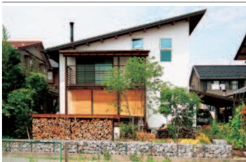
蛇籠と薪置場でゆるやかに道路と区切られた建物
