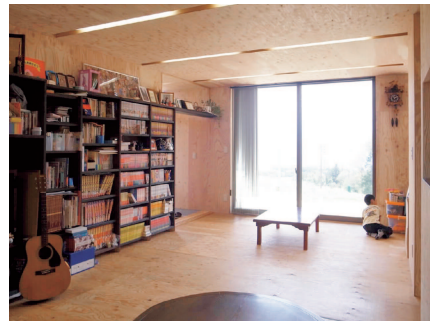
室内仕上げは針葉樹合板、建築主が塗装した本棚
