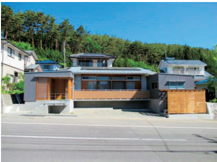
深い軒の出、ルーバーによる「風の通り道」の確保
