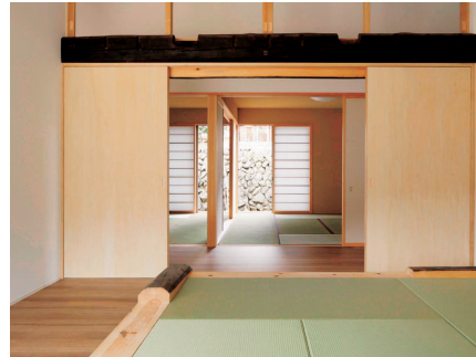
鴨居、框納まり 古材をカットしあえて綺麗な切断面を見せる
