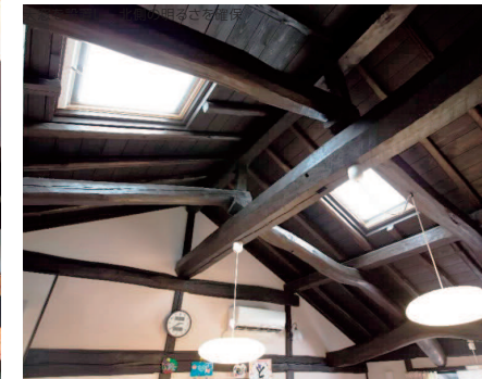
天窓を設置し、北側の明るさを確保
