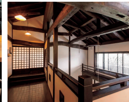
地元赤松の梁を残し、当時の雰囲気を復元した2階吹き抜けホール
