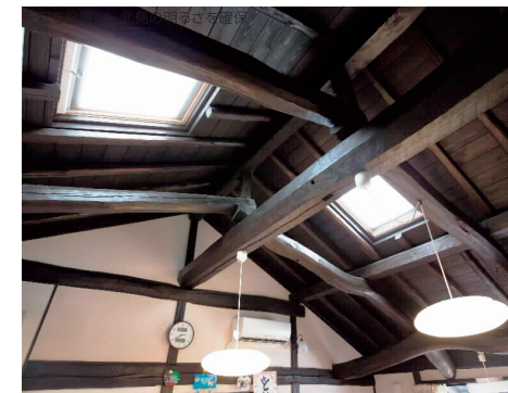
天窗を設置し、北側の明るさを確保
