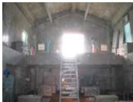
平成23(2011)年11月9日：紫外線処理棟の屋根を葺き終わり、外壁の仕上げが進んでいます。また、棟内も配管のための架台が完了しています。
