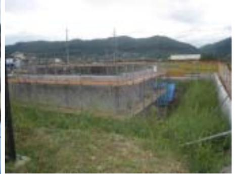
平成23(2011)年9月1日：紫外線処理棟の地下部分の壁や梁までできています。
