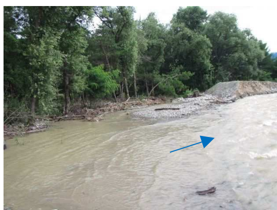
写真-5 池田町内鎌 被災状況 (令和 2 年 7 月)
