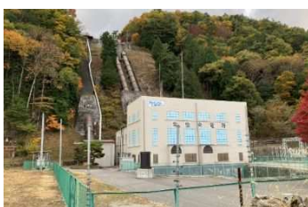
写真-7 常盤発電所
