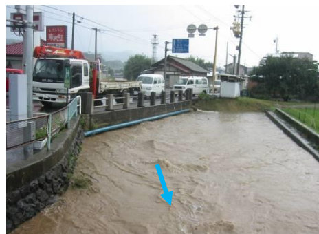
平成16年10月豪雨 矢の沢川での出水状況
