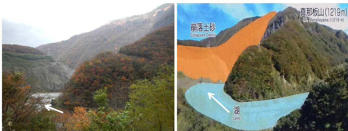
写真 1-13 真那板山の深層崩壊
