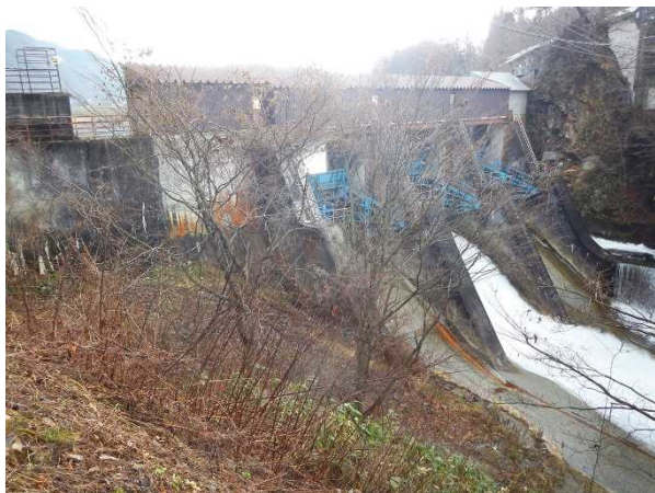
写真 1-16 姫川第二ダム
