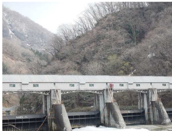
写真 1-17 姫川第三ダム
