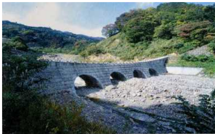
写真 2-1 直轄砂防事業（浦川スーパー暗渠砂防堰堤）
