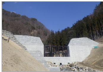
滝沢第2砂防堰堤（大鹿村・中川村）
