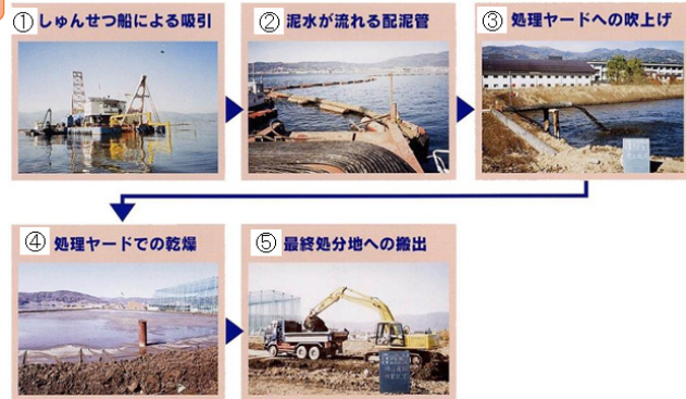
諏訪湖の浚渫の様子
