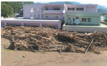
被災した要配慮者施設 (岩手県)
