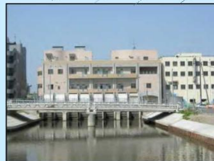
排水機場全景
