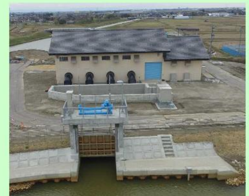
排水機場全景
