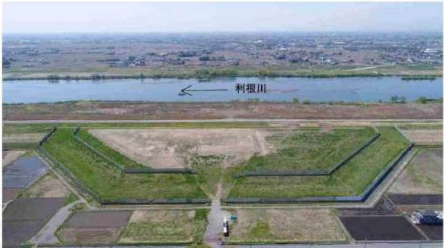
栄地区広域避難地(埼玉県加須市)
