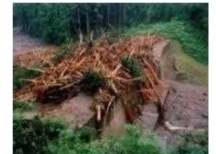
流木捕捉式治山ダム
