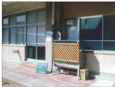
図 4.3.13 雨水貯留施設 設置例
