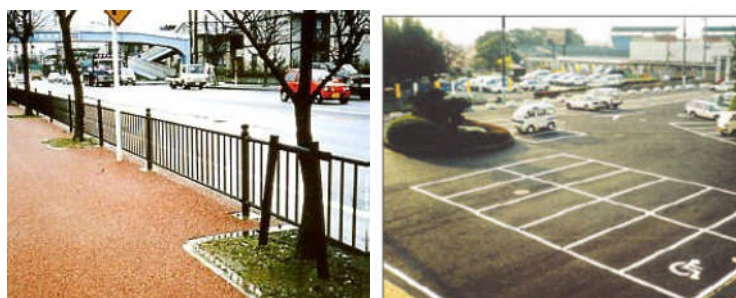
図 4.3.15 透水性舗装 施工例
