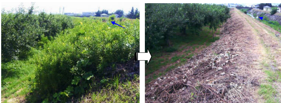
図 4.3.7 堤防除草実施状況
