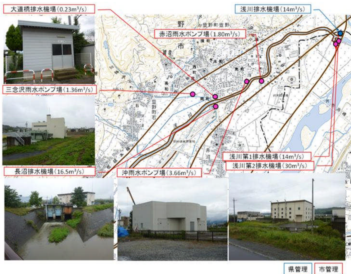
図 4.3.16 浅川下流部の排水機場・雨水ポンプ場管理状況
