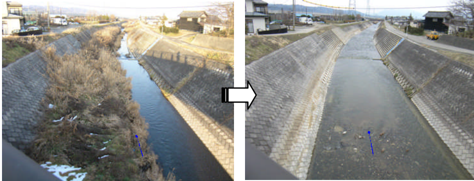
図 4.3.5 堆積土除去実施状況
