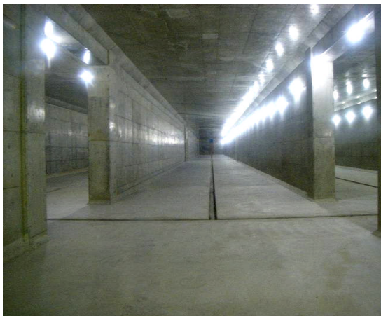
【運動公園雨水調整池】
