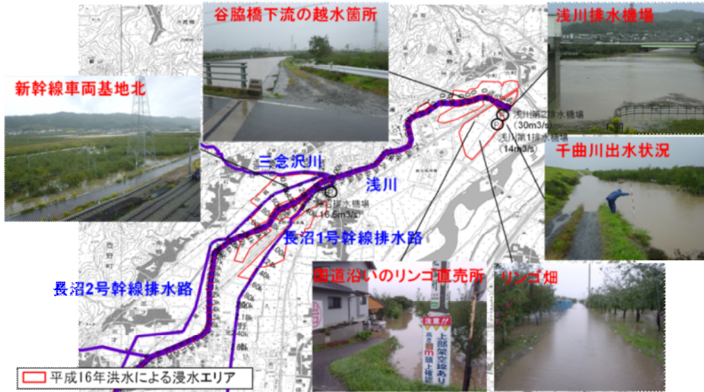
図 2.7.3 平成 16 年 10 月 台風 23 号の状況
