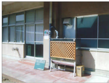
図 4.3.13 雨水貯留施設 設置例
