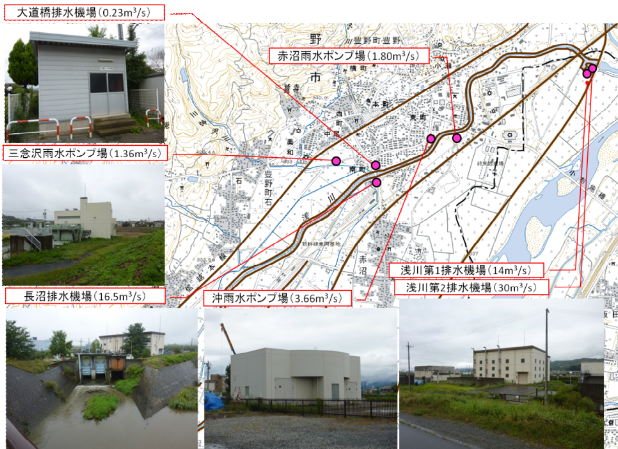
図 2.7.2 対象区域の排水機場・雨水ポンプ場設置状況
