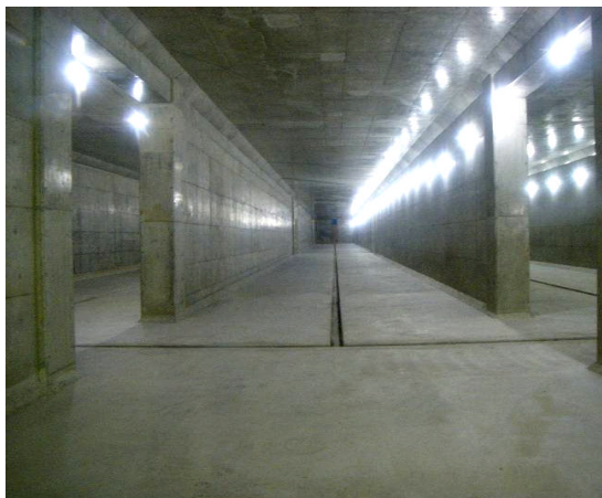
【運動公園雨水調整池】
