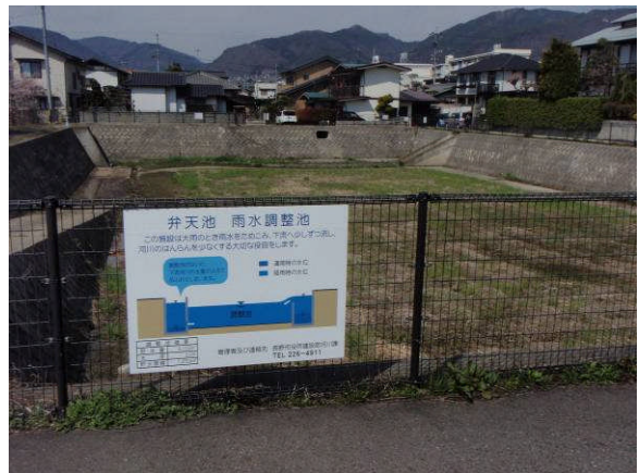
【弁天池雨水調整池】
