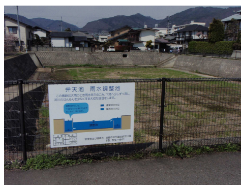
【弁天池雨水調整池】
