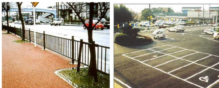
写真 4.6.3 透水性舗装 施工例
