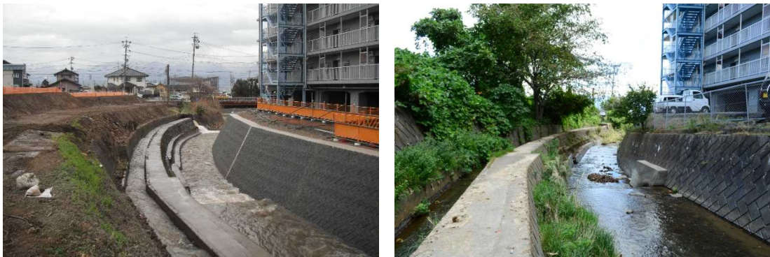
写真 4.3.1 河川改修箇所写真
