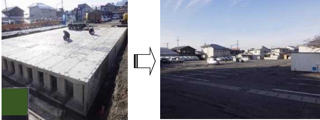
写真 4.5.4 長野市豊野支所地下貯留施設
