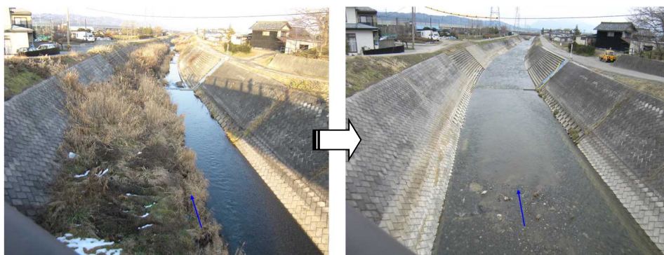
写真 4.6.1 堆積土除去実施状況
