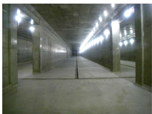
【運動公園雨水調整池】
