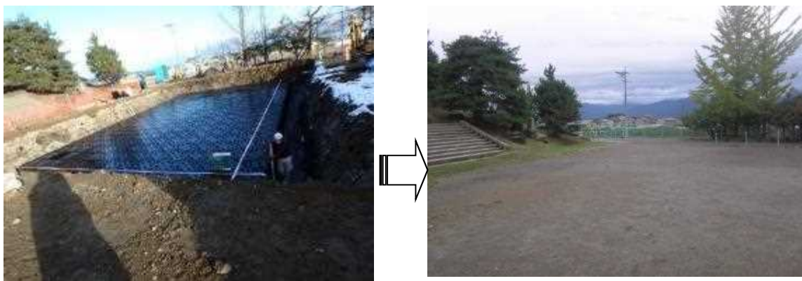
写真 4.5.3 長野市立豊野西小学校 学校校庭貯留施設
