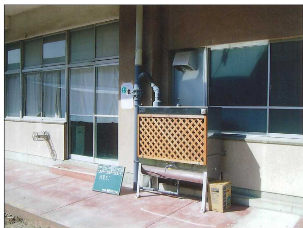
写真 4.5.2 雨水貯留施設 設置例
