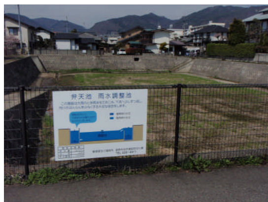
【弁天池雨水調整池】
