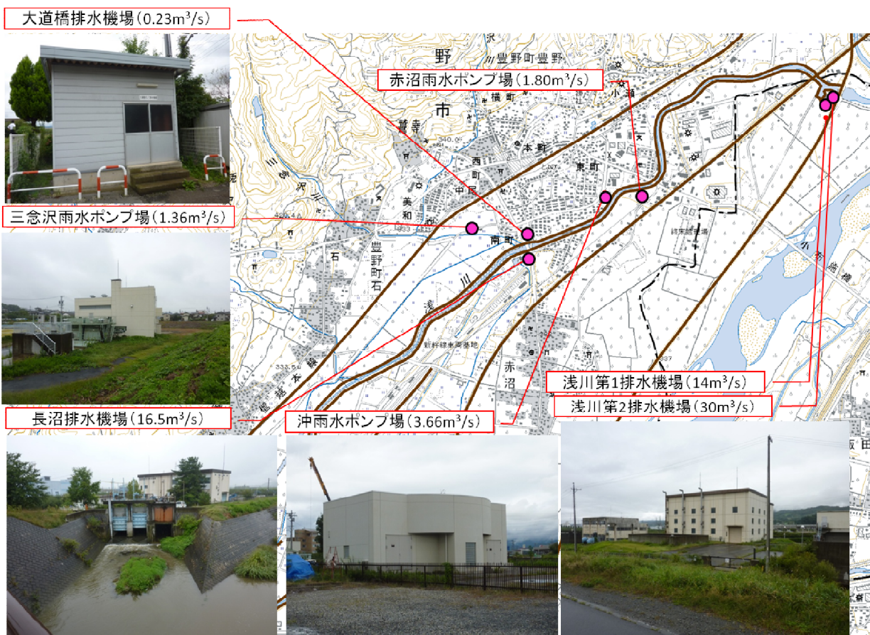
図 2.8.2 対象区域の排水機場・雨水ポンプ場設置状況
