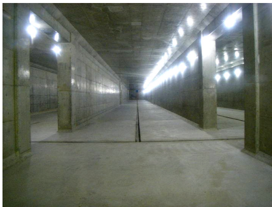
【運動公園雨水調整池】
