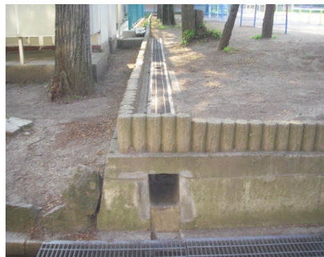
図 2.9.3 浅川流域内の学校校庭貯留施設整備状況
