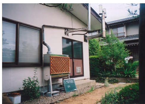
図 2.9.4 浅川流域内の雨水貯留施設設置状況
