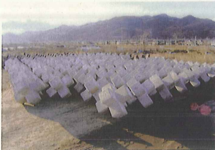
緊急対策用ブロックの備蓄
