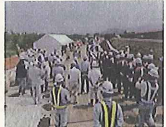
中島地区漏水対策工事見学会 (須坂市中島地区)(22年5月)
