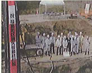
福島地区鋼製矢板最終打設 (須坂市福島地区)(21年11月)
