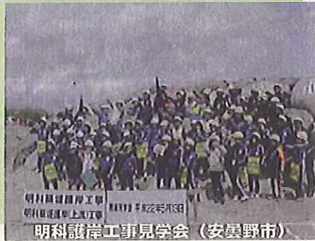
明科護岸工事見学会 (安曇野市)
