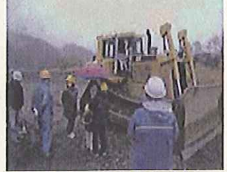
島高松根固補修工事見学会 (安曇野市豊科地区)(22年3月)
