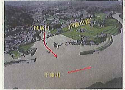
堤防整備中の中野市替佐地区浸水状況 (H18年7月)
