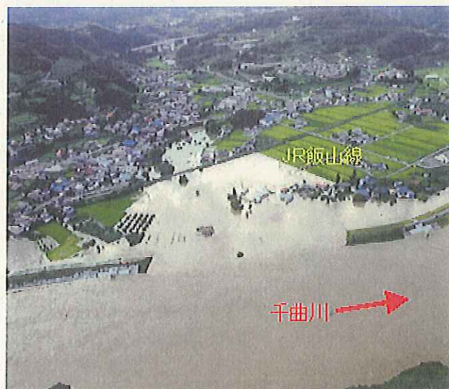
堤防整備中の替佐地区 浸水状況
