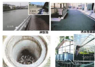
雨水貯留浸透施設の例
