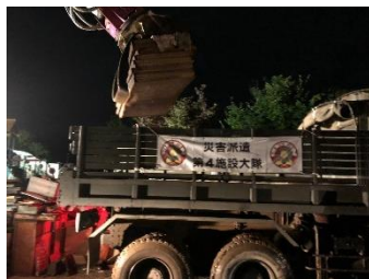
自衛隊による搬出作業
