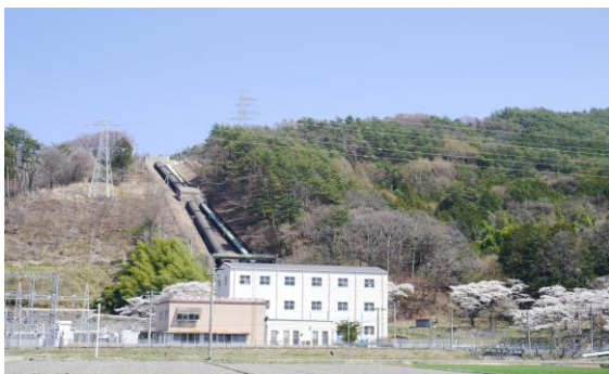
長野県企業局の春近水力発電所
