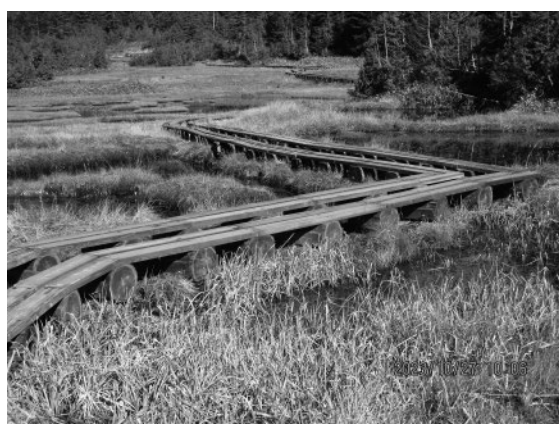
志賀山回遊線道路（歩道） 木道改修 （山ノ内町）
