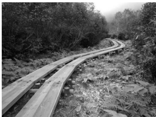
小谷村 柵池自然園 木道整備補修
