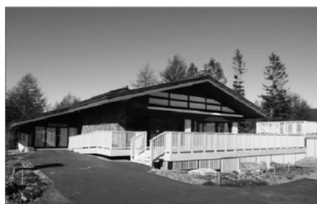
長野県霧ヶ峰自然保護センター
