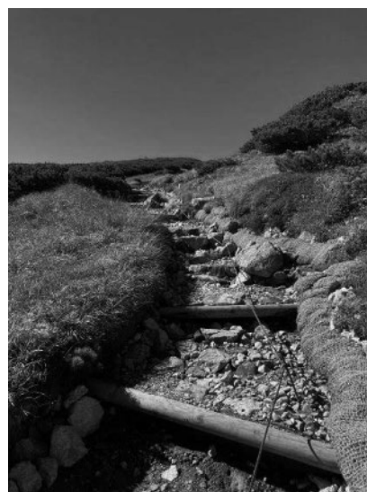
ネオアルプス 後立山連峰縦走線他 階段整備
