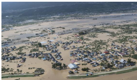
令和元年東日本台風による洪水
