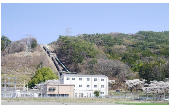
長野県企業局の春近水力発電所
