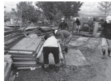
仮置場からの搬出作業
