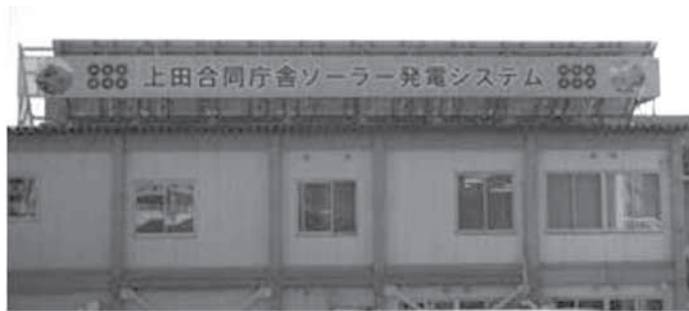
ソーラー発電システム
