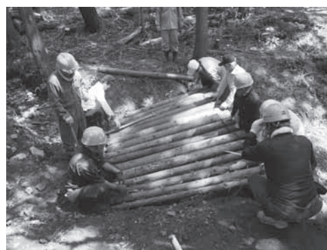
住民協働による遊歩道の整備
