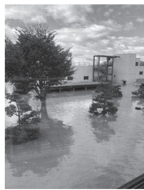
クリーンピア千曲 浸水状況 (R元. 10. 13)
