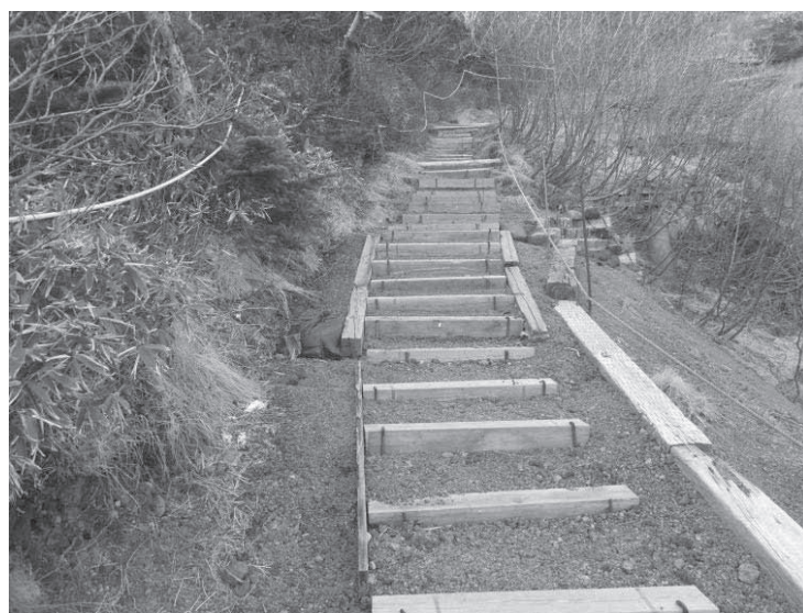
木製階段改修後（王滝村）
