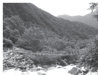
松本市 横尾穂高線道路（歩道）整備
