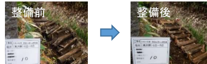
【壊れた階段の再整備】
