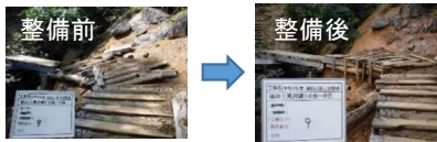
【傾いた栈道の再整備】
