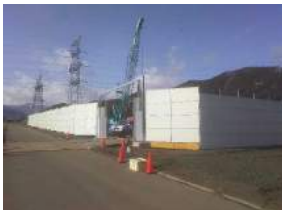
写真7.1-2 防音パネル(シート)の設置状況(左：令和元年10月5日撮影，右：平成31年2月16日撮影)
