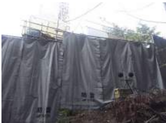
写真7.1-2 防音パネル(シート)の設置状況(左：令和元年10月5日撮影，右：平成31年2月16日撮影)
