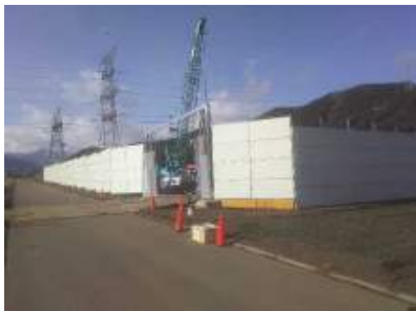
写真 6. 1-1 (1) 騒音・振動の測定状況
