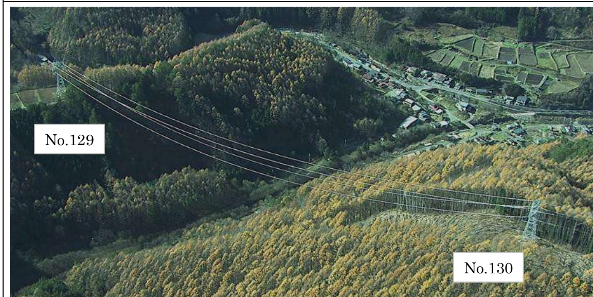
No. 129～130 送電線下伐採状況
