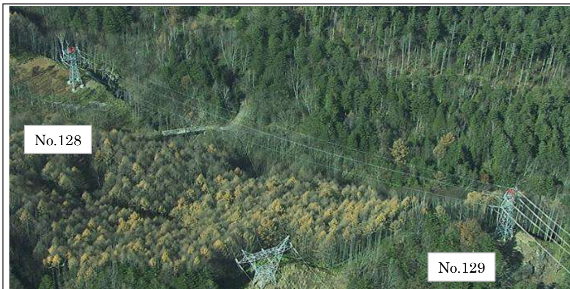
No. 128～129 送電線下伐採状況
