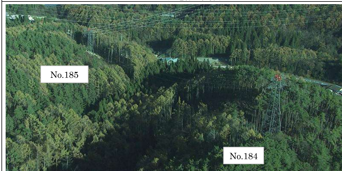
No. 184～185 送電線下伐採状況
