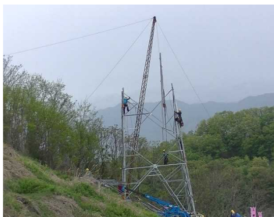
写真7.3-3 台棒工法による鉄塔組立工事の例
