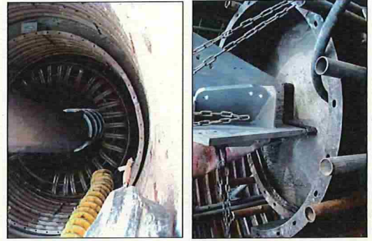
基礎材据付と柱体部の
