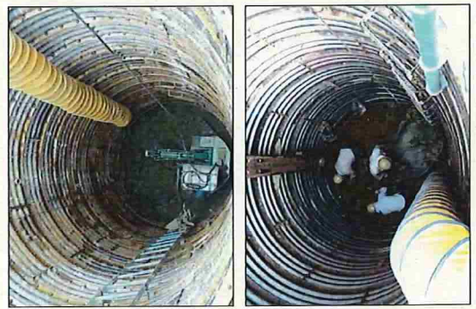
鋼製支保工を土留めに
