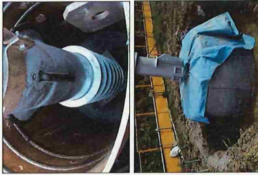
脚材の据付と基礎の仕上り状況
