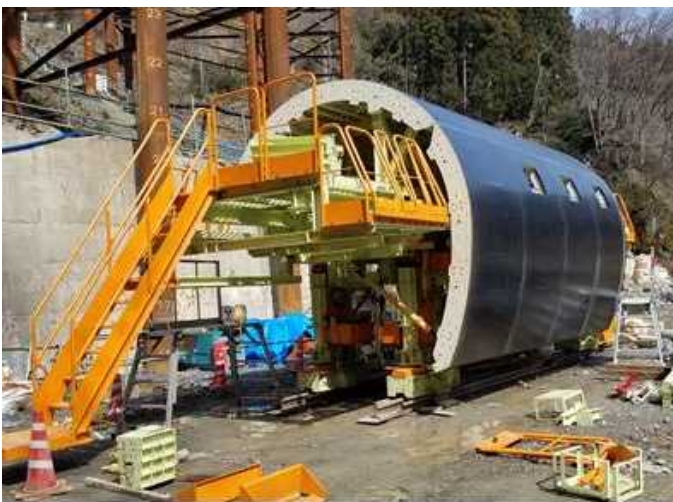
鋼製型枠の組立状況 （2019. 3. 27撮影）
