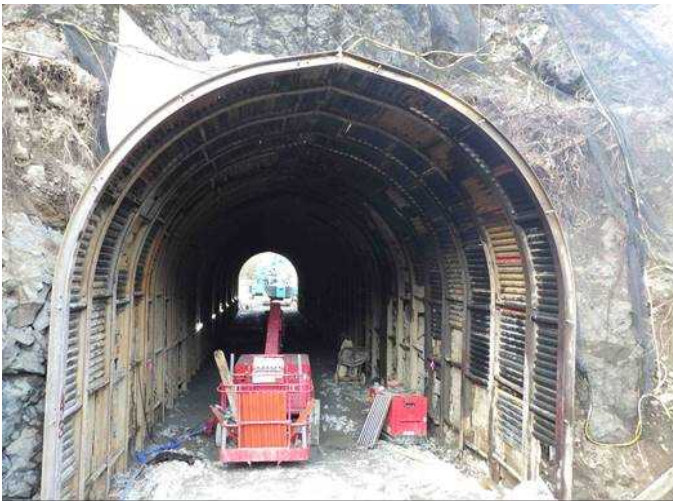
連絡トンネル工事の状況（上流より） （2019. 3. 27撮影）
