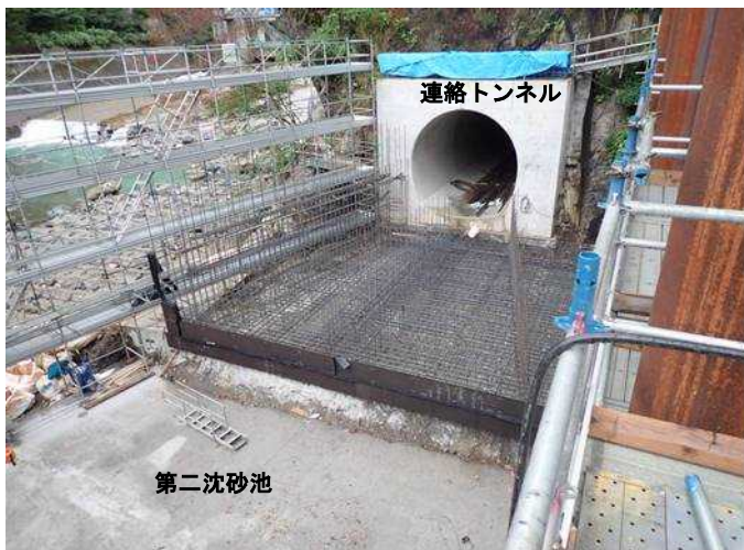
第二沈砂池施工状況（下流より） （2019. 9. 27撮影）
