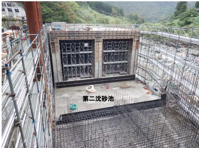
第二沈砂池施工状況（上流より） （2019. 9. 27撮影）
