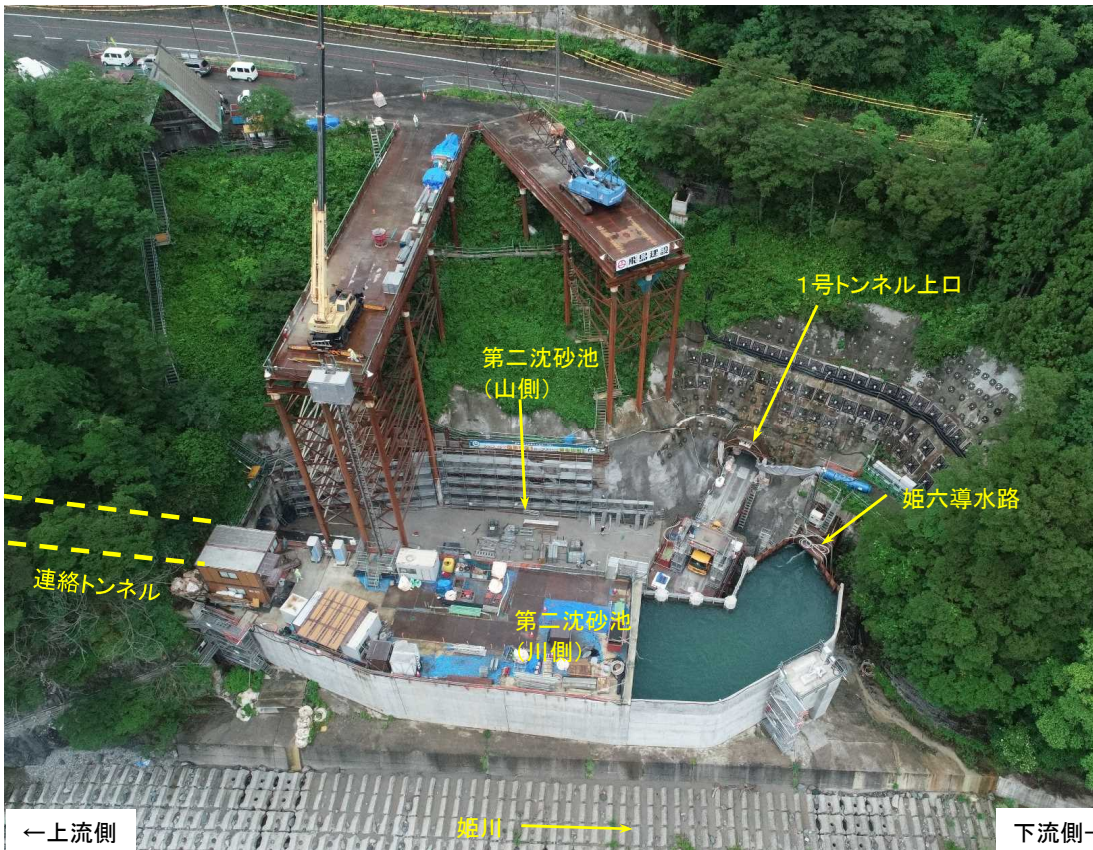
全景(川側より)
