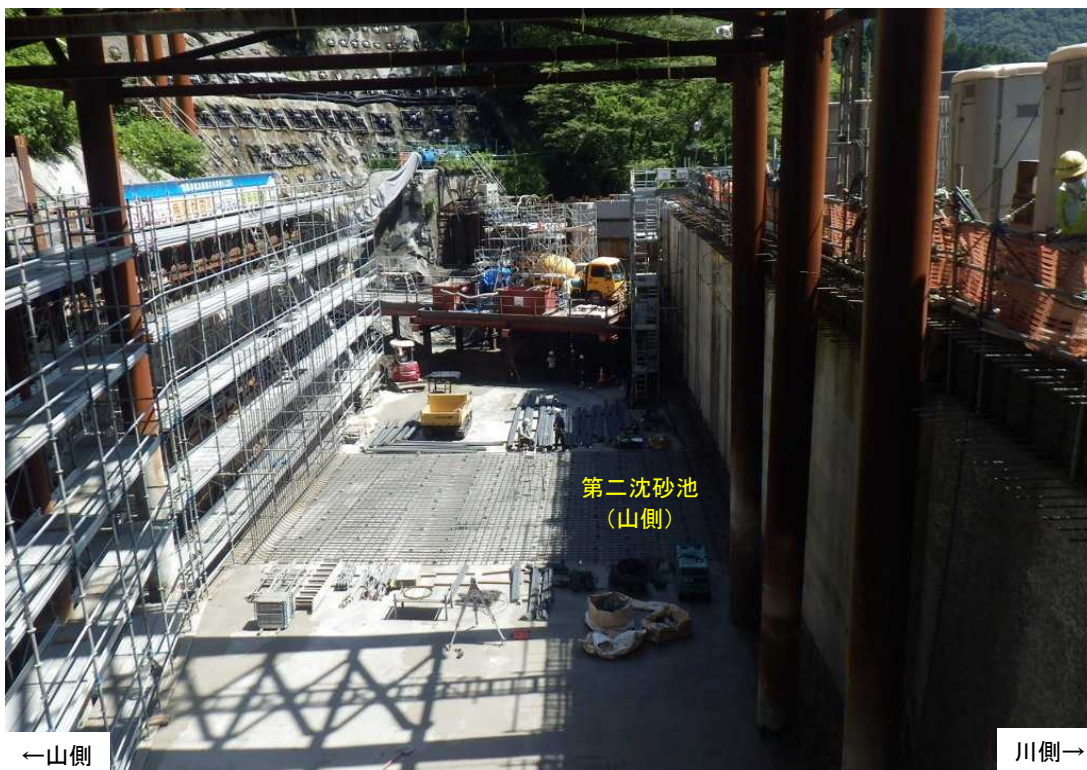
第二沈砂池(山側) 施工状況(上流より)
