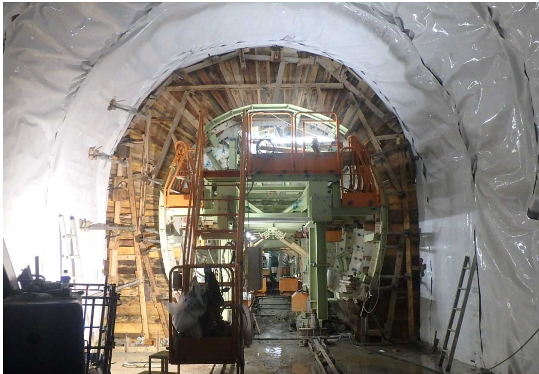
1号トンネル施工状況 (下流より)
