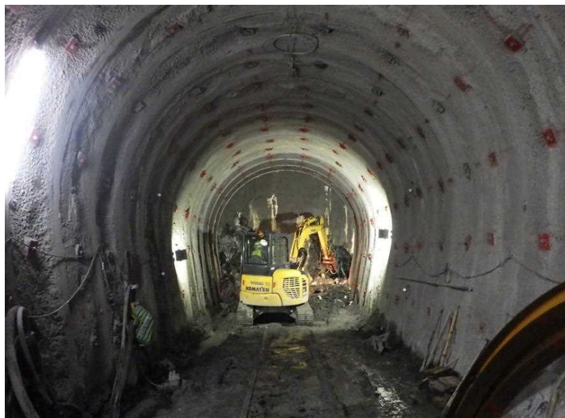
1号トンネル掘削状況(上流より)
