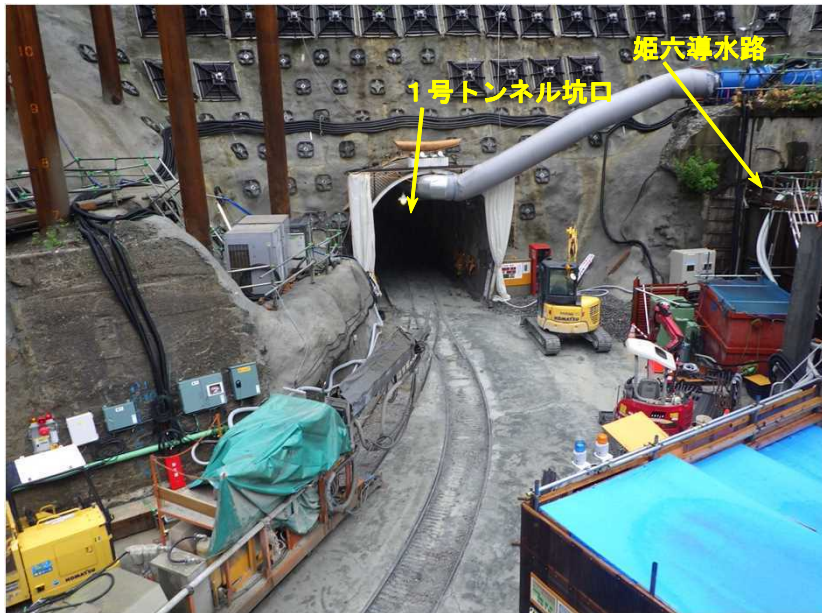
1号トンネル坑口付近状況 (上流より下流望む)
