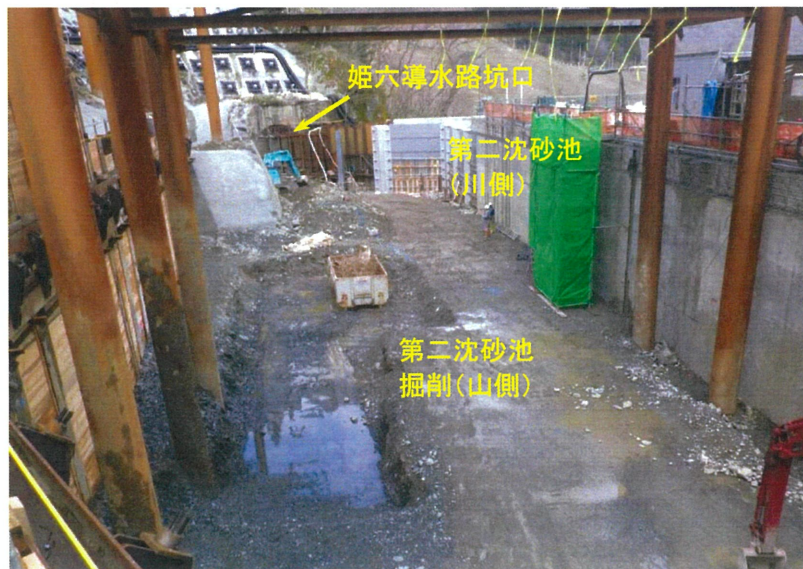
第二沈砂池掘削状況(上流より) (2020.03.30撮影)
