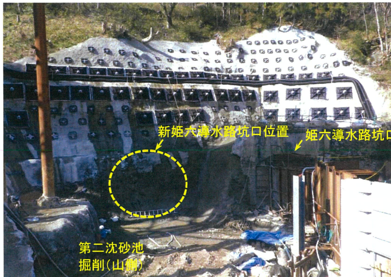
導水路坑口掘削及び 上部法面補強状況(上流より) (2020.03.30撮影)
