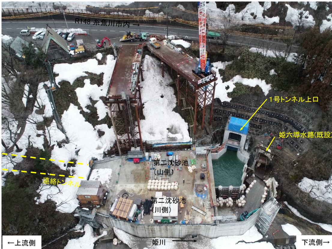
全景(川側より)
