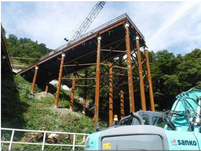
作業構台 （H30. 9. 26撮影）
