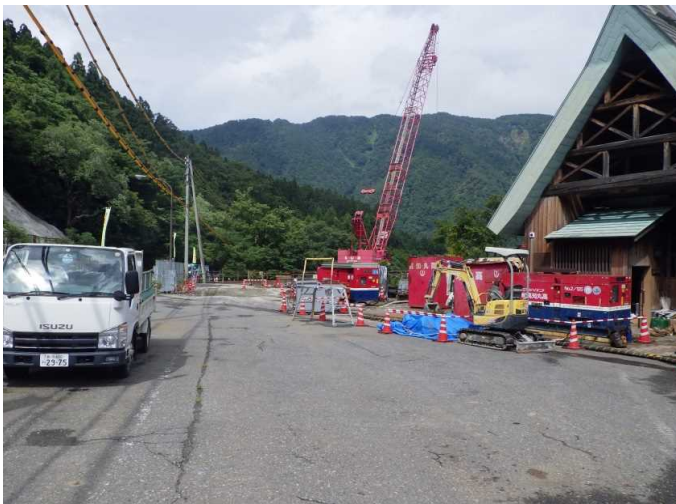
工事ヤード （H30. 8. 28撮影）
