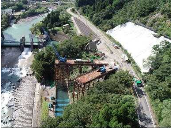
全景（下流側より） （H30. 9. 26撮影）
