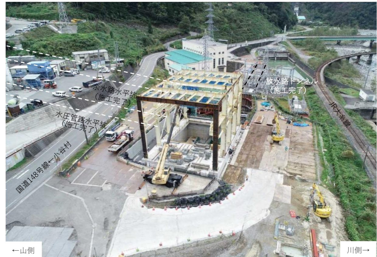
④発電所側全景 (上流より)
