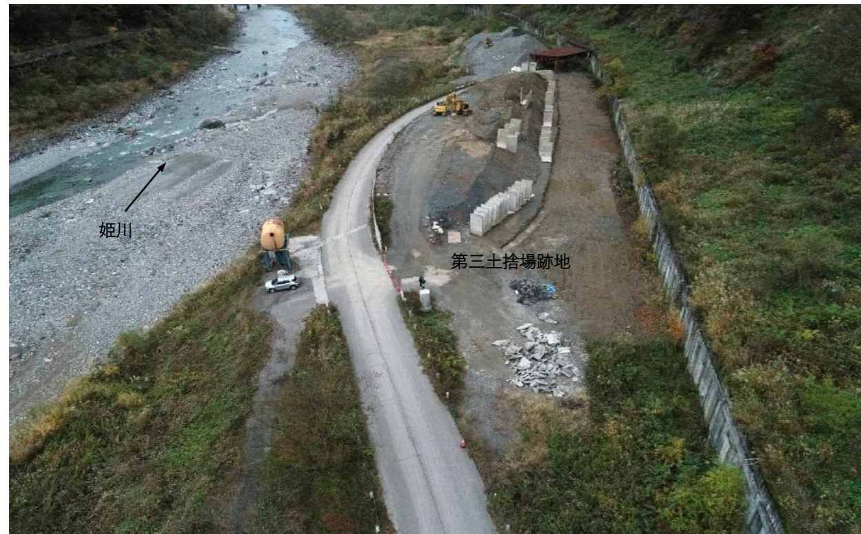
② 第三土捨場 (上流より全景) ※1
