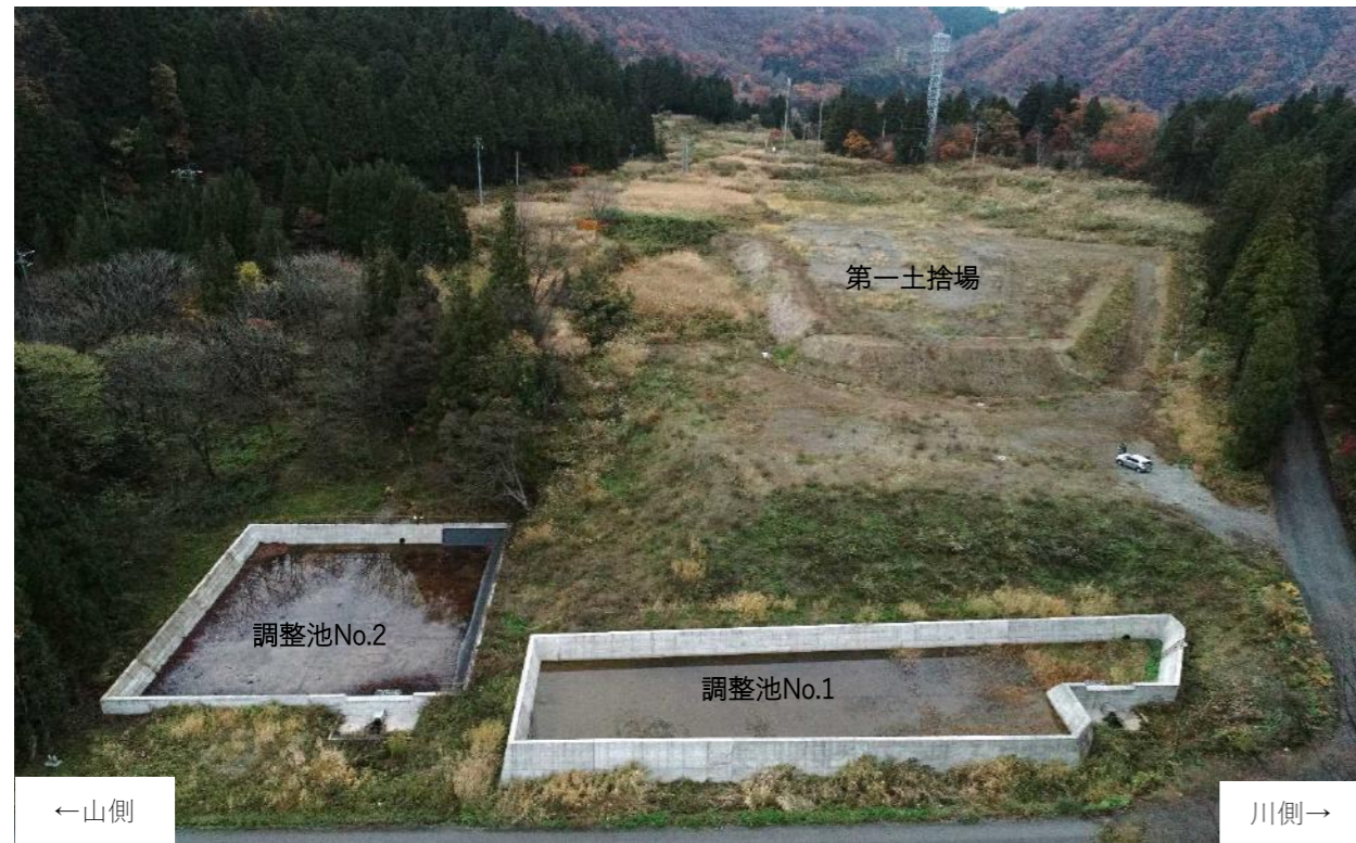
① 第一土捨場(上流より全景)
