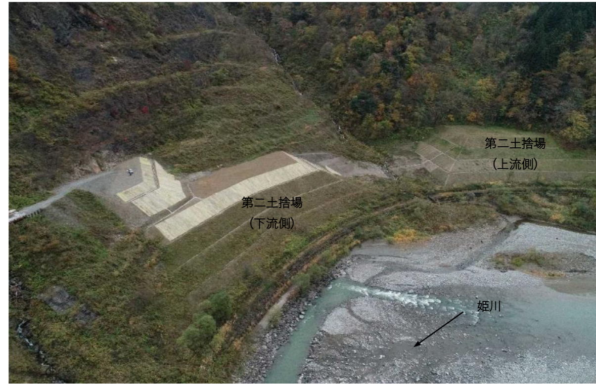
③ 第二土捨場 (対岸より全景)
