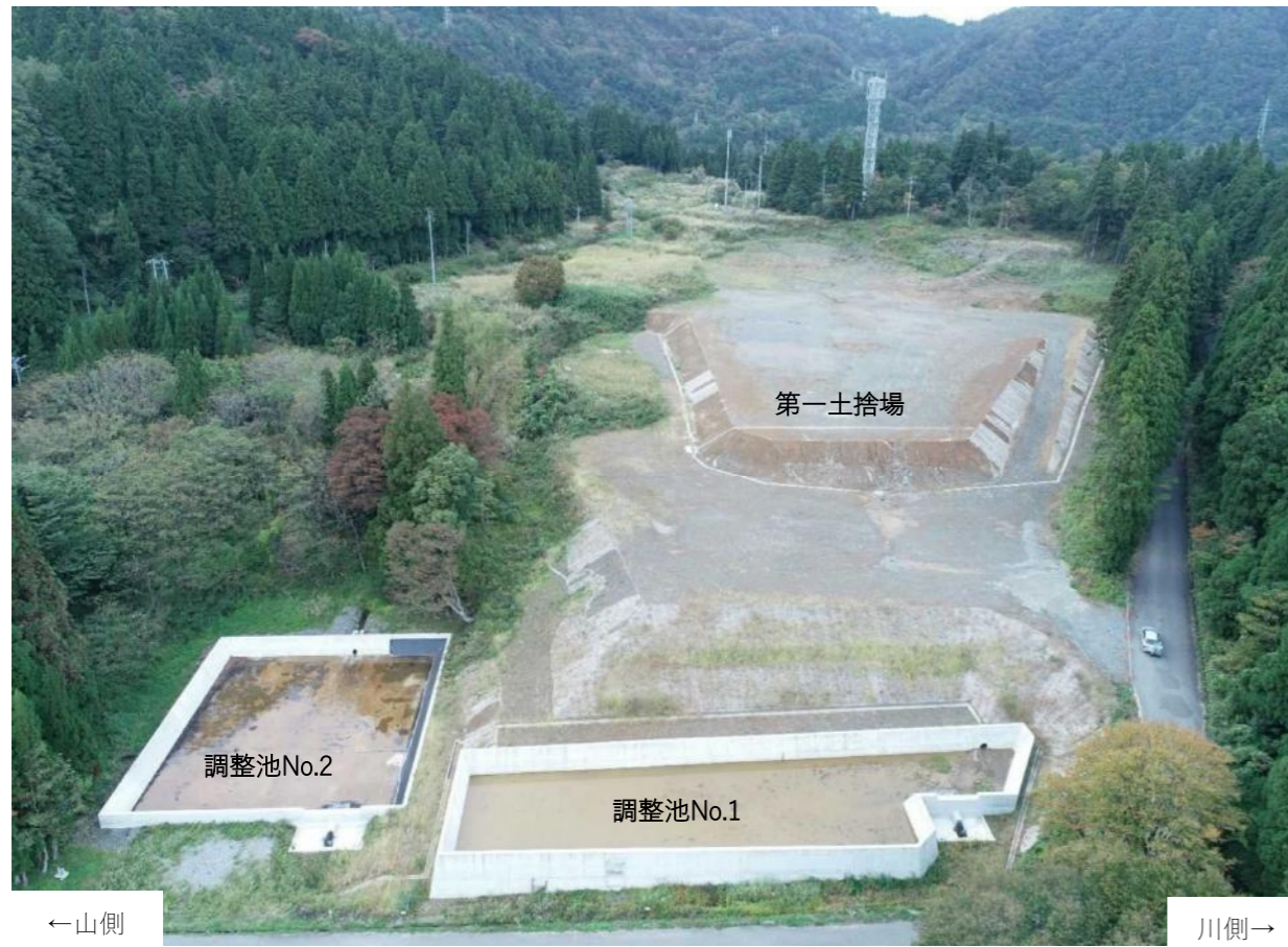
①第一土捨場(上流より全景)
