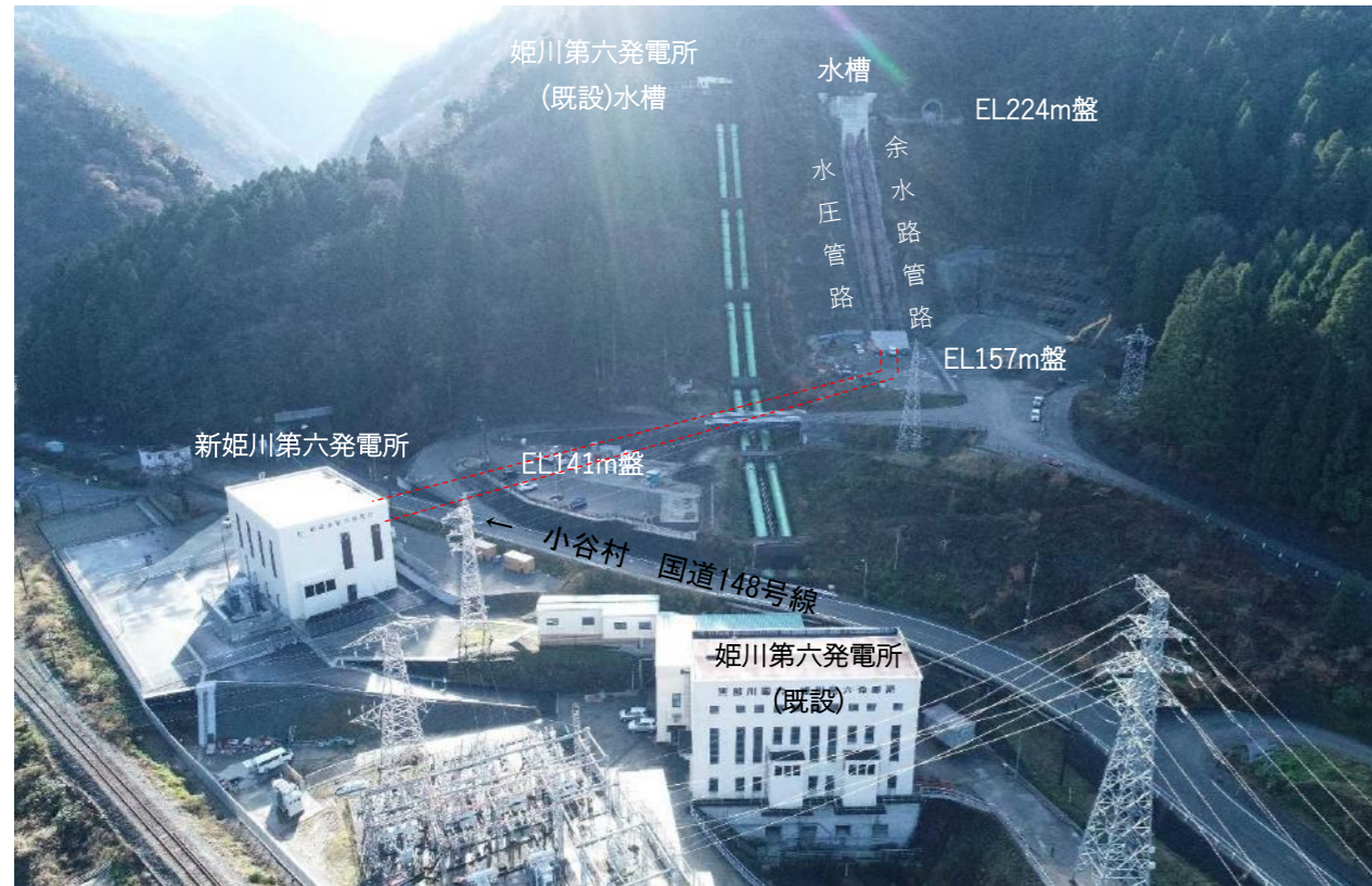
② 水圧管路・水槽余水路（露出部）全景（国道側より）…2022年12月撮影
