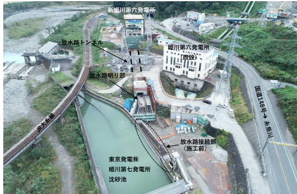
⑤発電所～放水路 (下流より)
