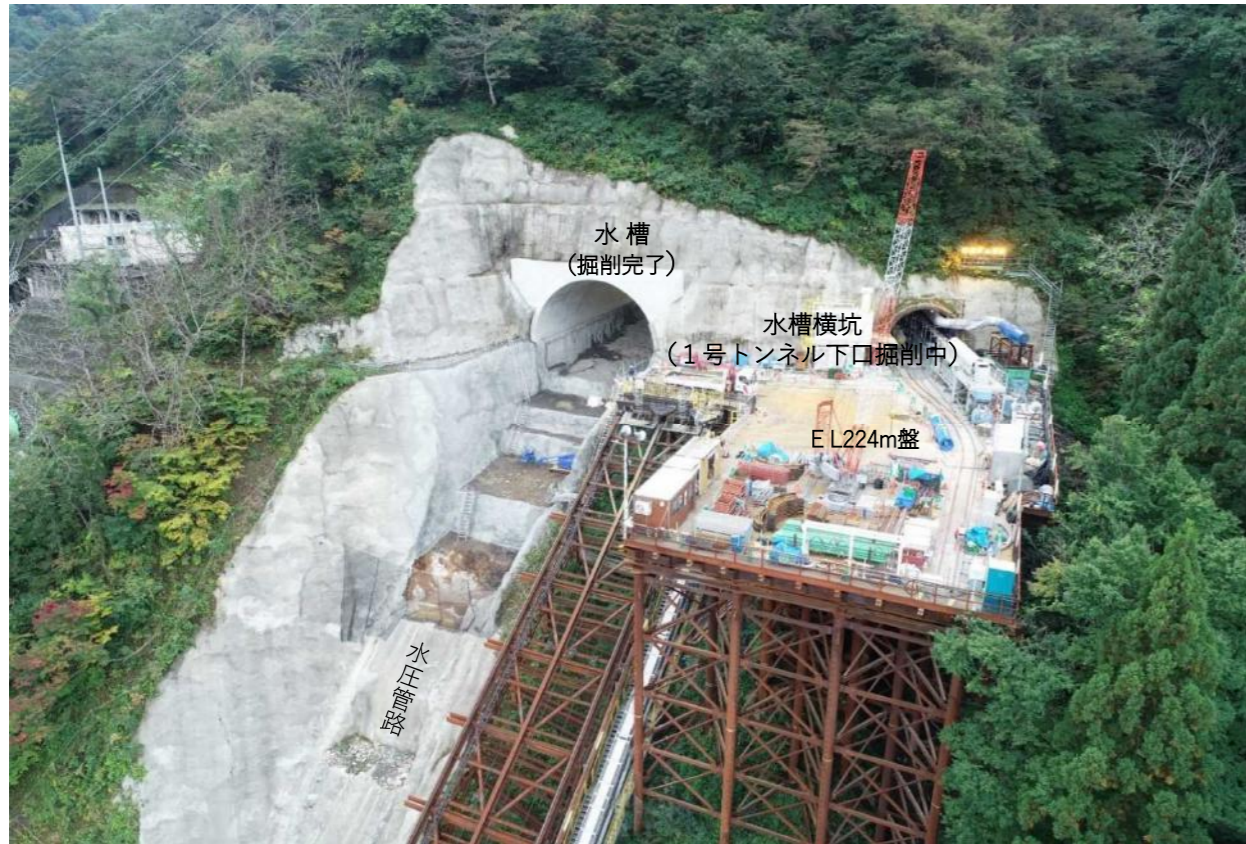
②EL224m盤施工状況
