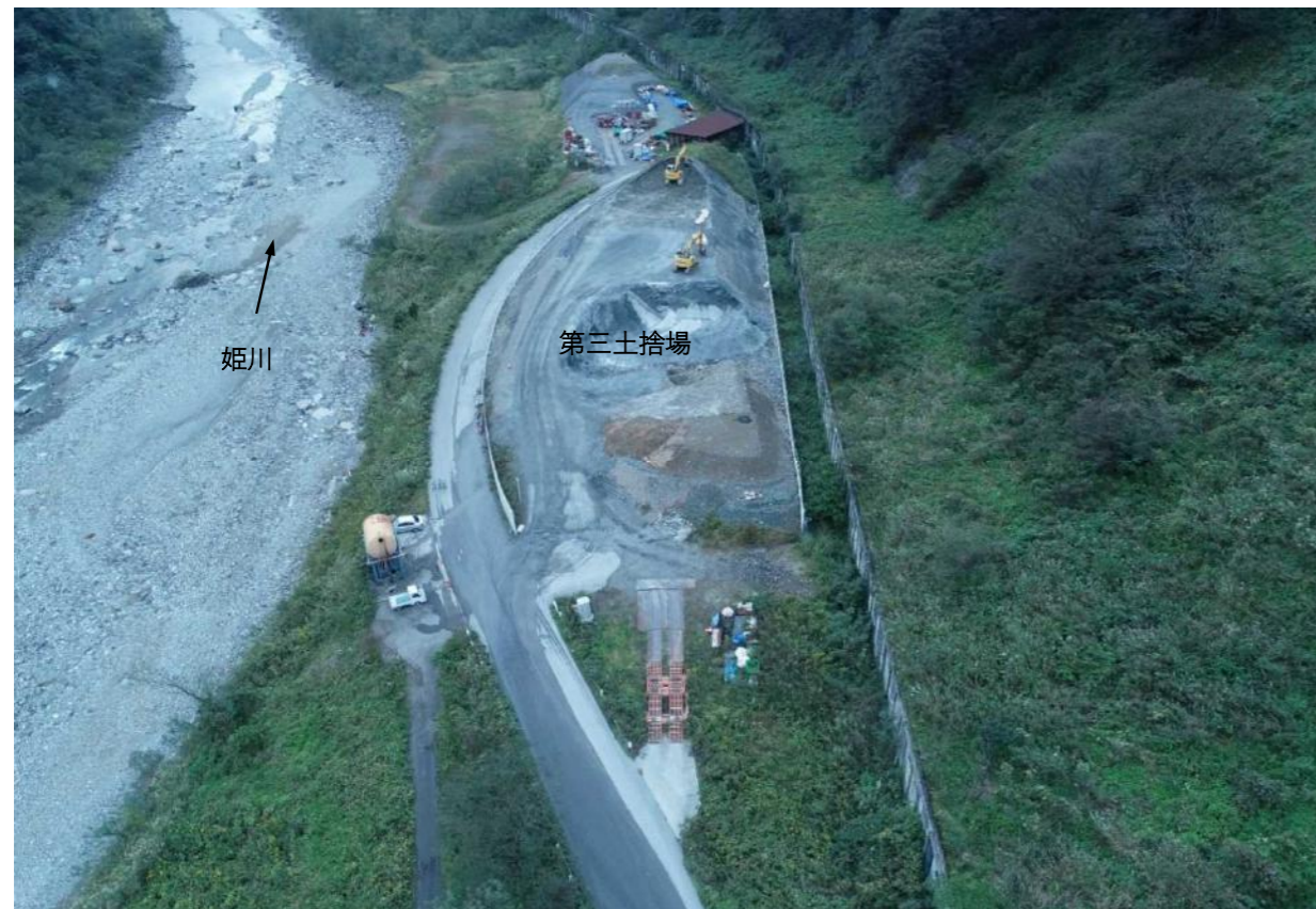
②第三土捨場(上流より全景)
