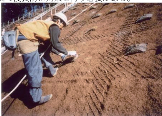
写真-5.6 ユニット苗工の施工状況
