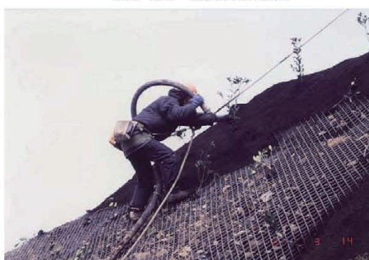
写真-5.5 苗木設置吹付工の施工状況
