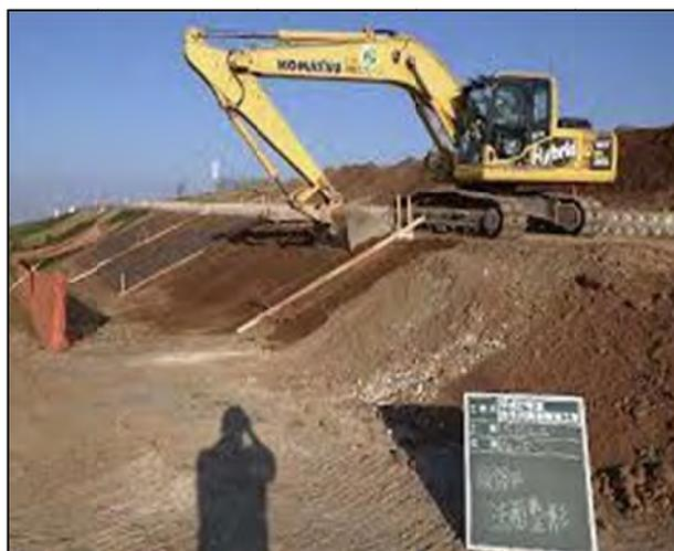
写真 1-6-7 盛土法面整形工事参考写真
