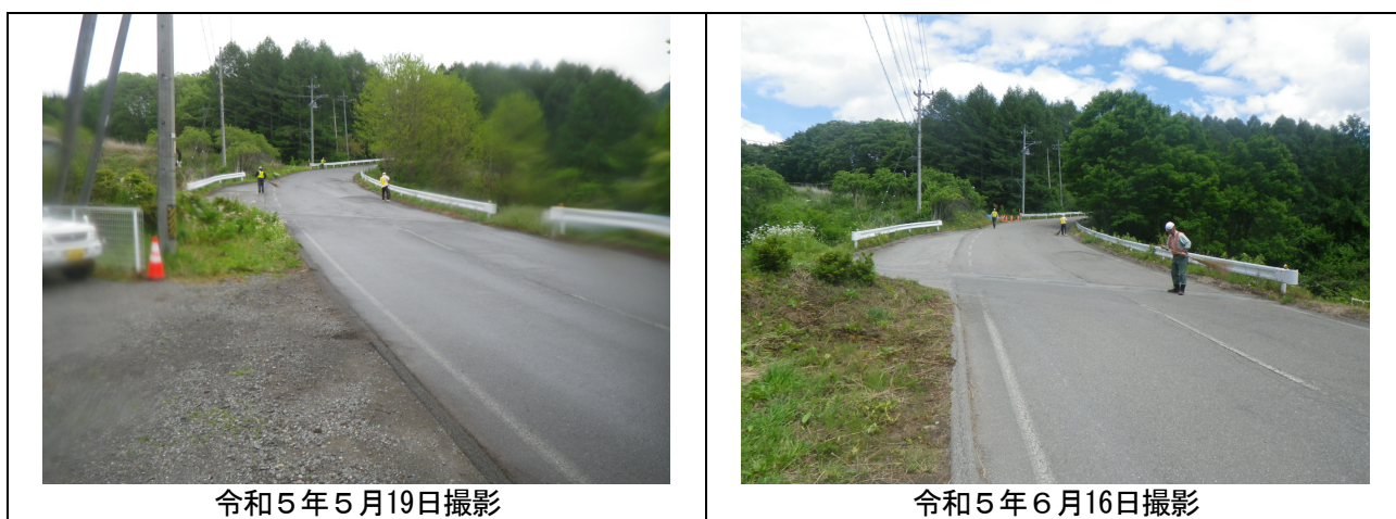
写真4-6：工事用車両出入口の路面清掃の状況
