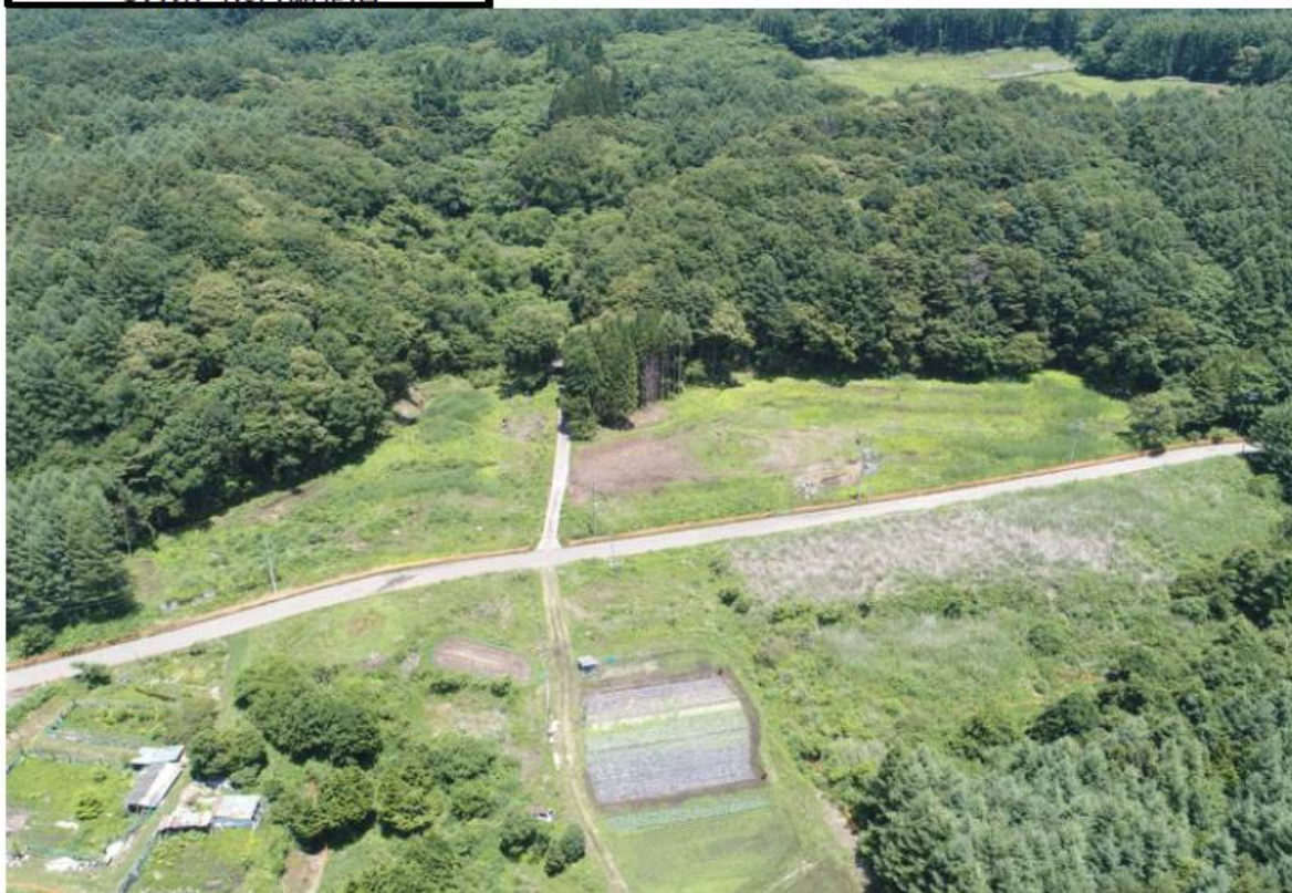
写真3-2(3) 工事の進捗状況写真 (④ No.4調整池まわり：令和5年6月30日時点)
