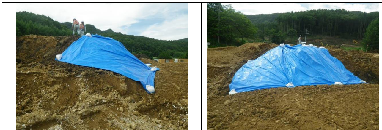
写真4-10：表土保全土のシート養生状況（令和5年6月29日撮影）
