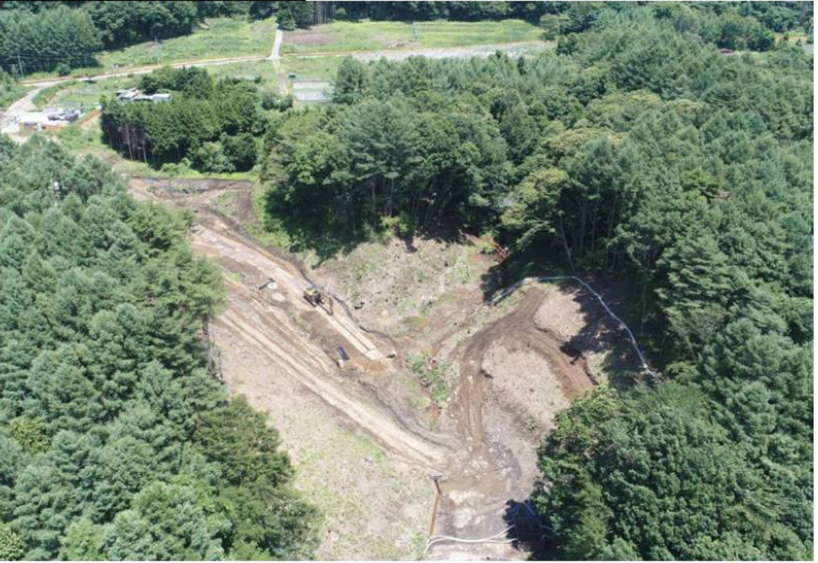
写真3-2(5) 工事の進捗状況写真 (⑥ No.6 調整池まわり：令和5年6月30日時点)
