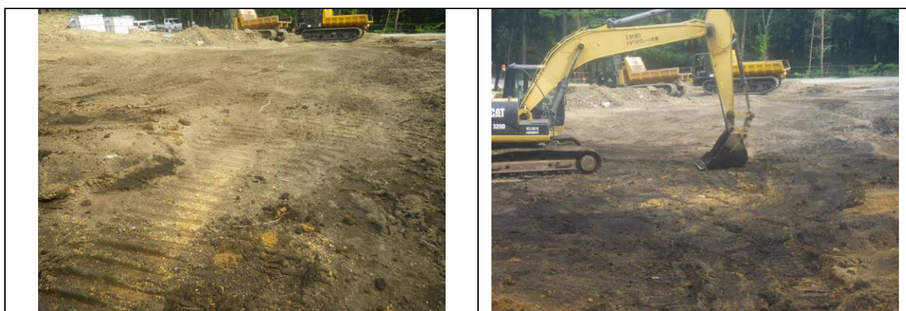
写真4-9：集中豪雨予報を見据えた土面の平滑化による雨養生の状況（令和5年6月21日撮影）
