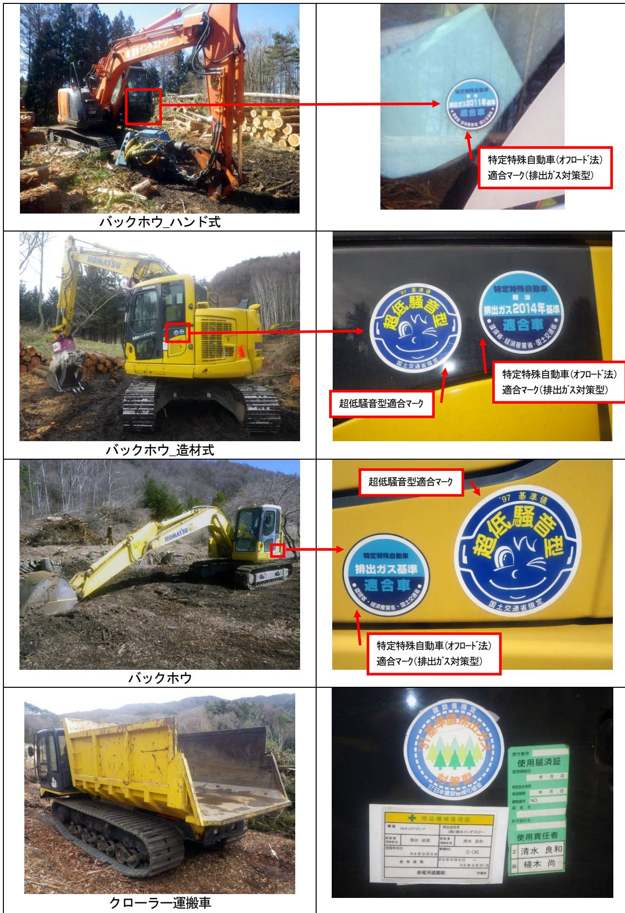
写真4-7：排出ガス対策型・超低騒音型建設機械の使用状況（令和5年3月20日撮影）
