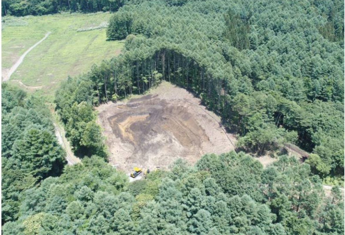
写真3-2(7) 工事の進捗状況写真 (⑧ No.8調整池まわり：令和5年6月30日時点)
