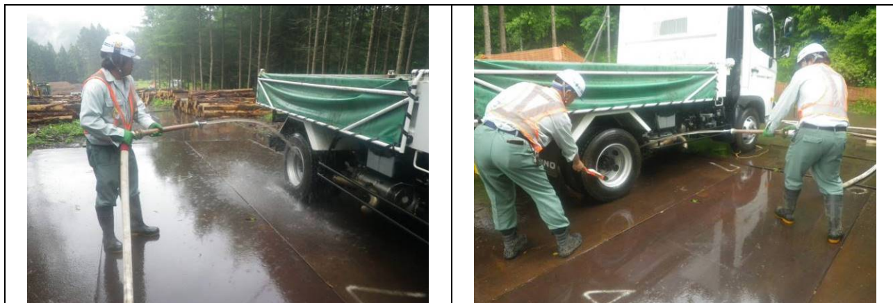
写真4-5：工事用車両のタイヤ洗浄状況（令和5年6月30日撮影）
