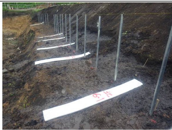
透水マットの設置状況（令和5年6月14日撮影）
