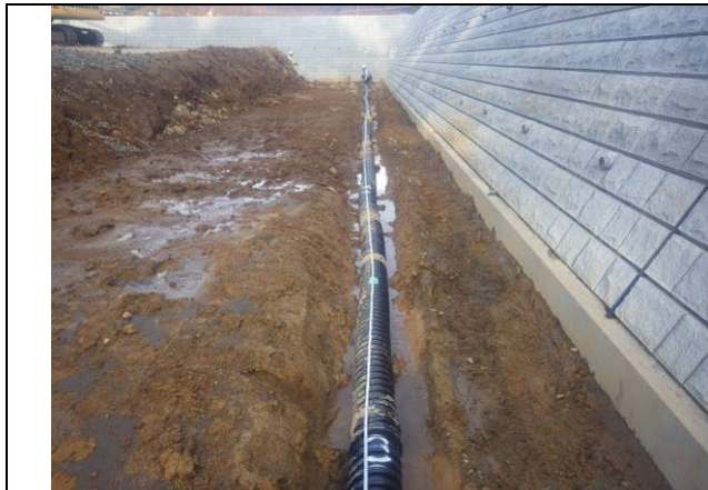
暗渠排水管の設置状況（令和5年6月29日撮影）
