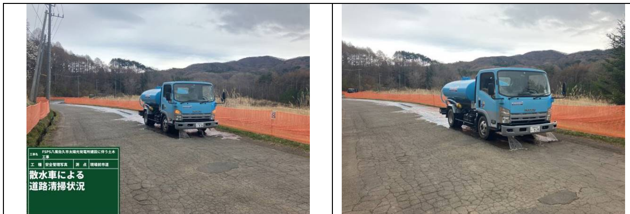
写真4-8：工事区域内の走路における散水状況（令和5年4月7日撮影）
