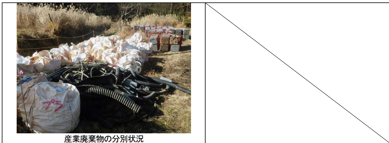
写真4-27：既設発電所撤去に係る産業廃棄物の分別状況（令和4年10月29日撮影）
