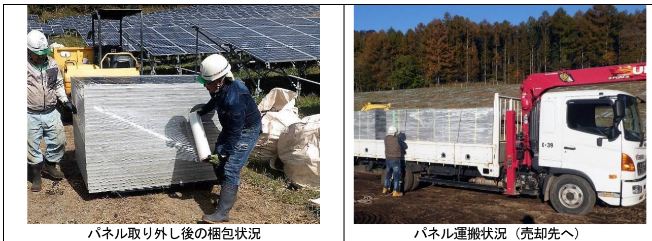
写真4-25：既設発電所撤去に係る売却用の太陽光パネルの梱包・運搬状況（令和4年10月11日撮影）
