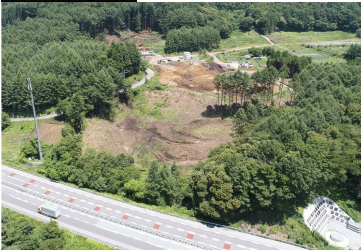
写真3-2(4) 工事の進捗状況写真 (⑤ No.5 調整池まわり・土仮置き場：令和5年6月30日時点)
