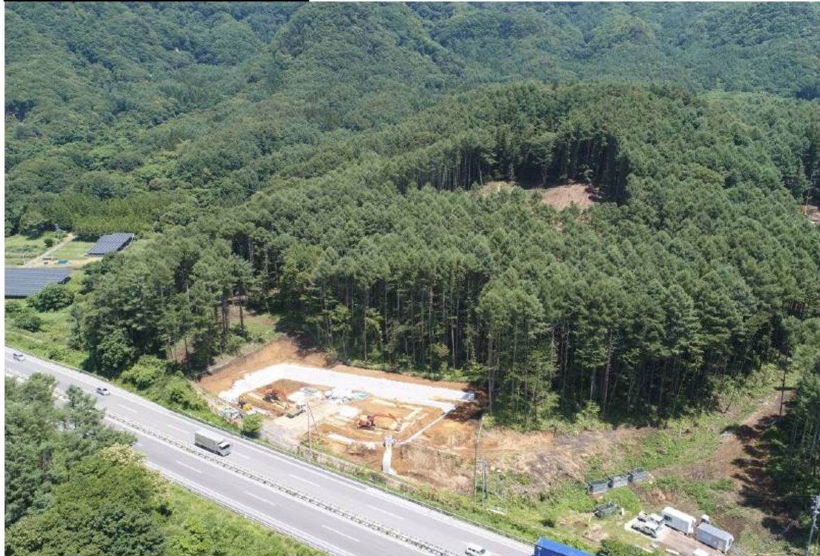
写真3-2(1) 工事の進捗状況写真 (①・③ No.1・No.3調整池まわり：令和5年6月30日時点)
