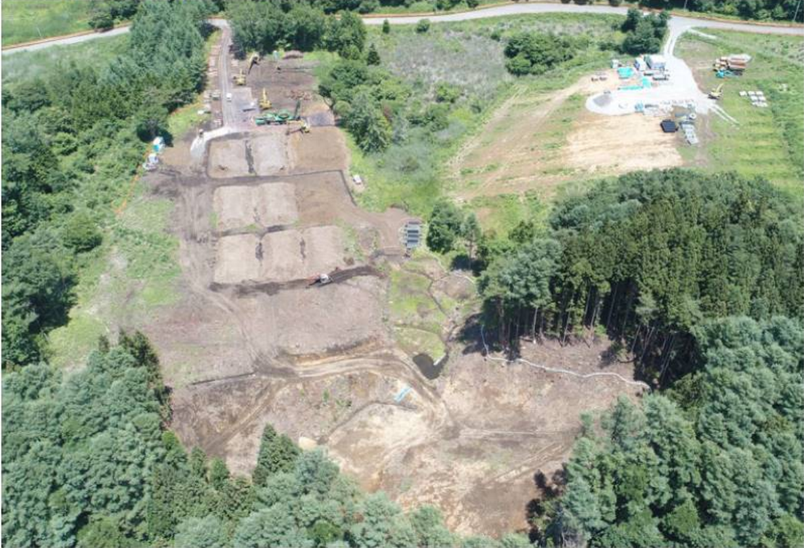
写真3-2(6) 工事の進捗状況写真 (⑦ No.7調整池まわり・チップヤード：令和5年6月30日時点)
