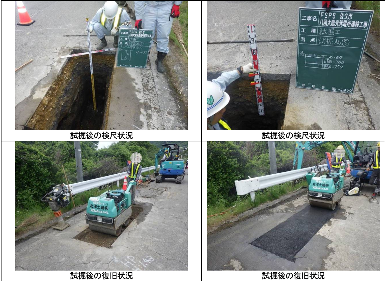
写真4-23：送電線の地下埋設工事に係る試掘状況（令和5年5月22日撮影）
