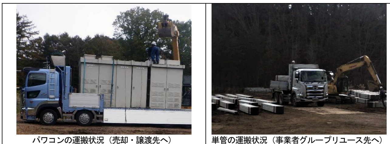
写真4-26：既設発電所撤去に係る売却・譲渡用のパワーコンディショナ及びリユース用の単管の運搬状況（令和4年10月27日撮影）
