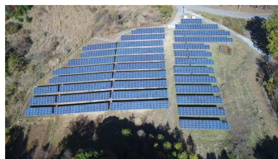
計画地南東側の発電所
