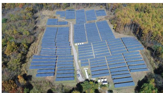
計画地北東側の発電所
