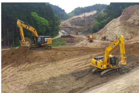
写真1.1.5-10 造成工事のイメージ
