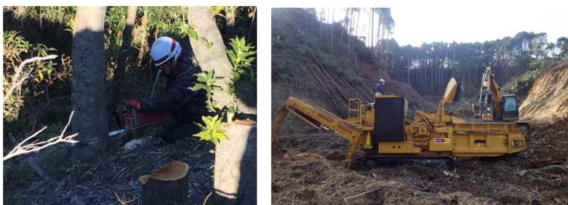
写真1.5-8 伐採工事のイメージ (左：伐採状況、右：チップ化作業状況)
