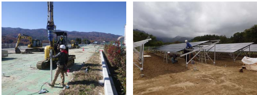
写真1.5-11 太陽光パネル設置工事のイメージ (左：架台設置、右：パネル設置)
