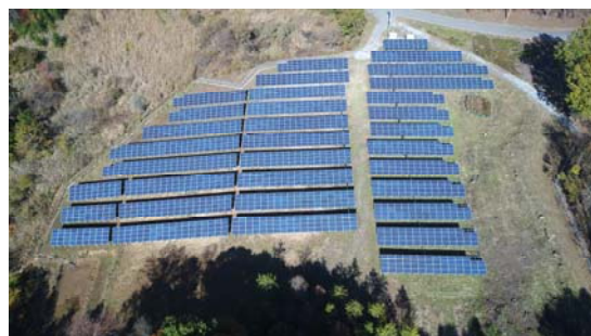
計画地南東側の発電所
