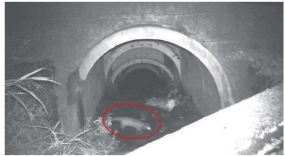
写真 5. 2. 1. 10 アーチカルバート上流部を通るハクビシン
