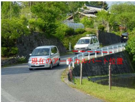
写真 5. 2. 1. 3 着手前の道路状況
