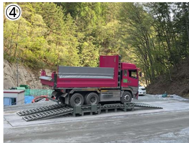
タイヤ洗浄機の設置
