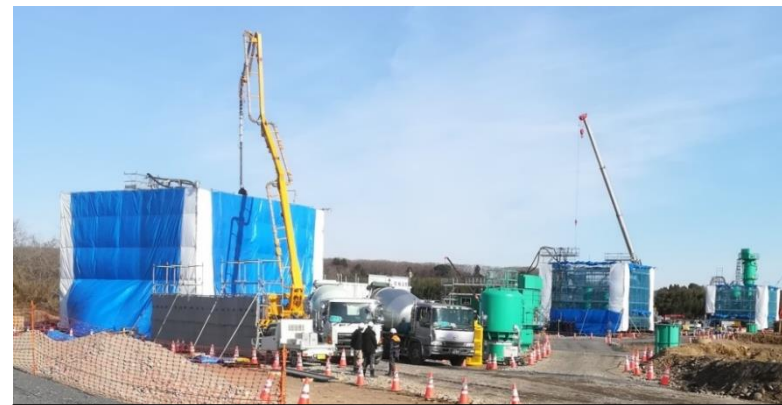
⑥橋脚部コンクリート打設
