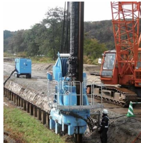
①鋼矢板打込み
