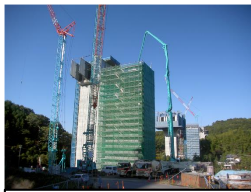
⑥橋脚部コンクリート打設
