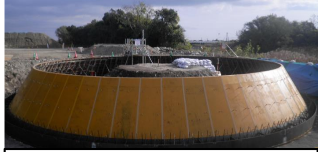
①作業室構築
