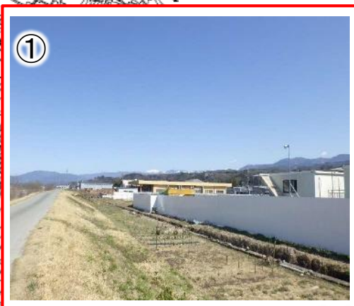
① 仮囲いの設置
