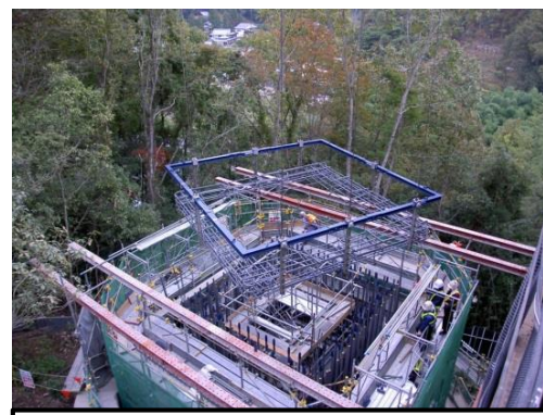
⑤橋脚部鉄筋組立
