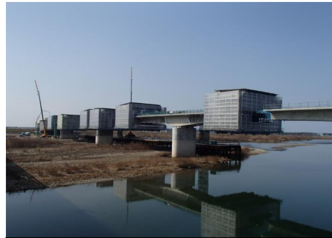
③張出施工
