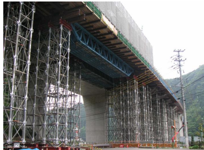
①支柱式支保工、②仮設梁設置
