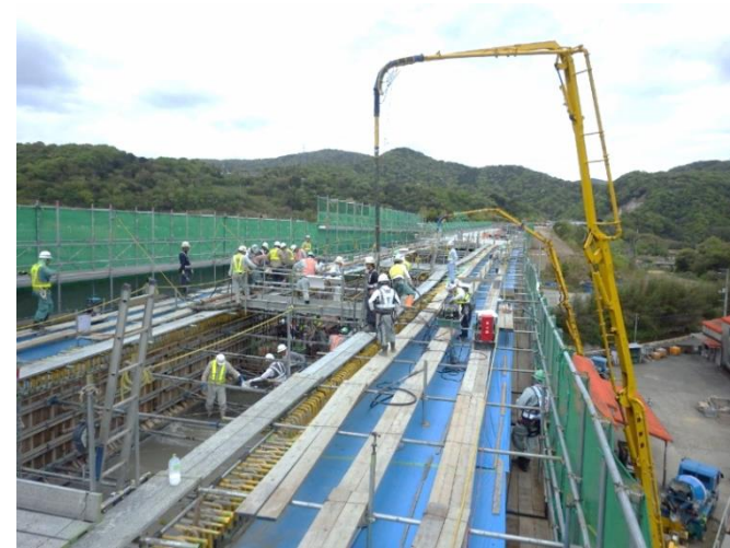
④上部工コンクリート打設
