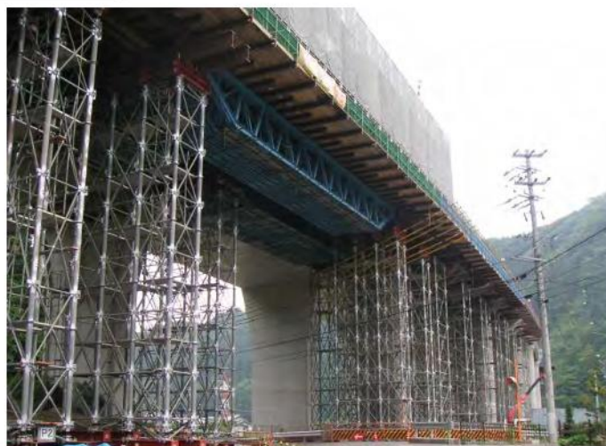
①支柱式支保工、②仮設梁設置
