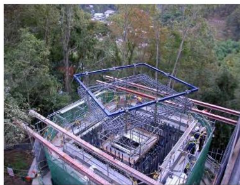
⑤ 橋脚部鉄筋組立
