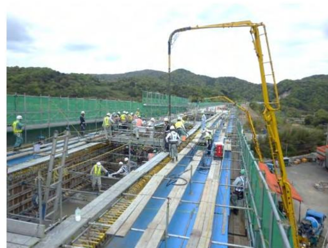
④上部工コンクリート打設
