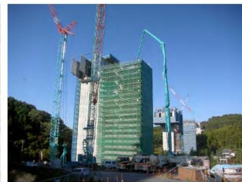
⑥ 橋脚部コンクリート打設
