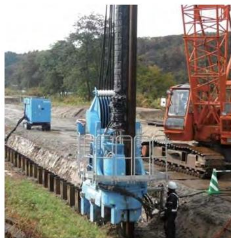
① 鋼矢板打込み
